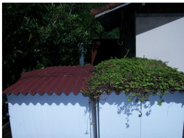
Figura 6: Módulos para medição de temperatura
