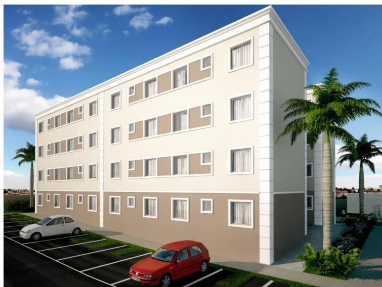
Figura 3: Fachada do Residencial Rondônia
