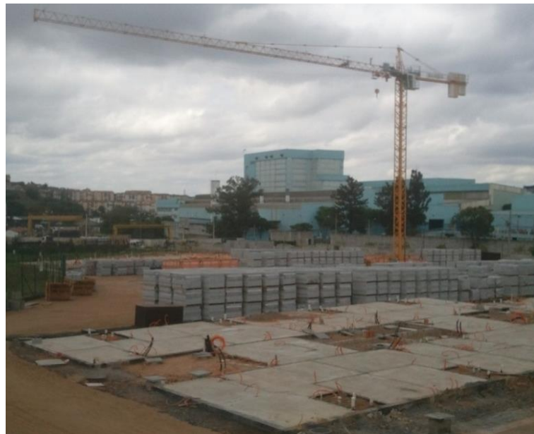
Figura 5: Armazenamento dos blocos
