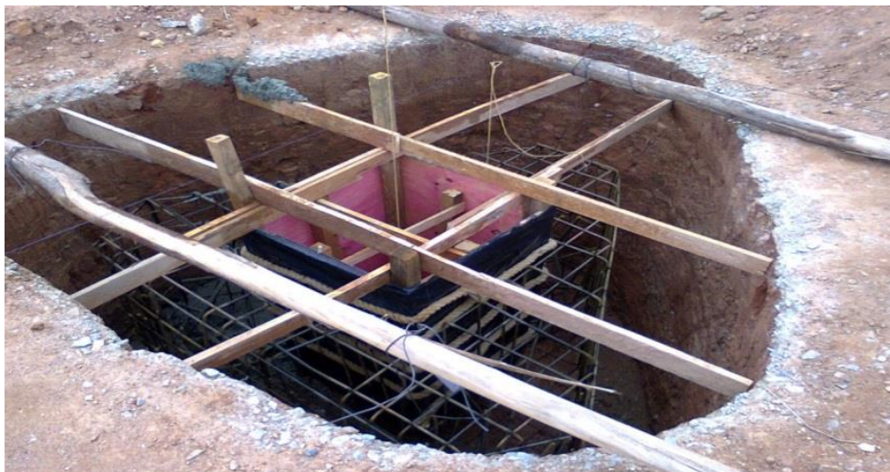
Figura 4: Bloco de Coroamento.
