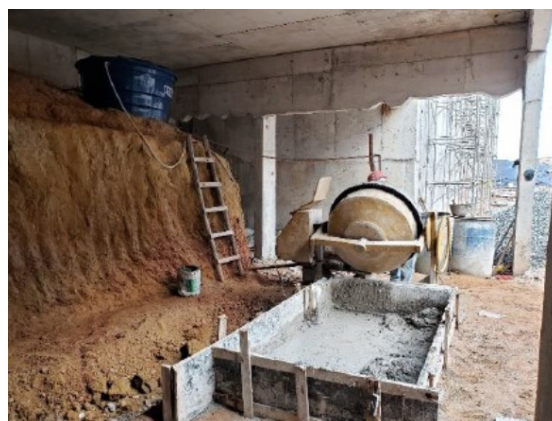
Figura 7: Área de operação e lavagem de betoneira isolada
