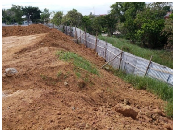
Figura 6: Proteção de todo limite do canteiro com tapume metálico
