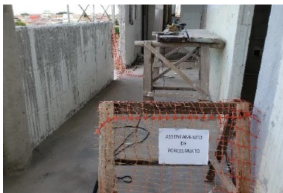
Figura 17: Isolamento de ambiente com execução de atividade
