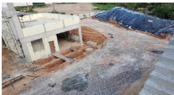
Figura 11: Via interna da obra estabilizada com brita e entulho
