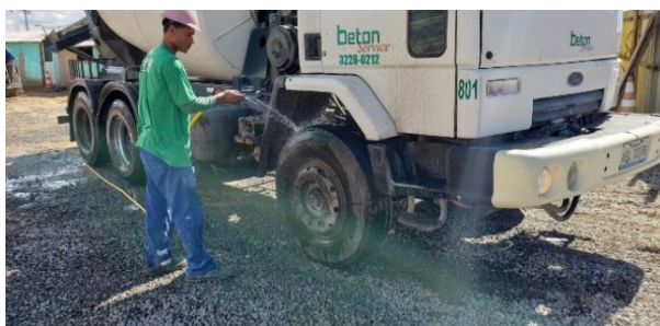
Figura 13: Lavagem das rodas de veículos que saem da obra
