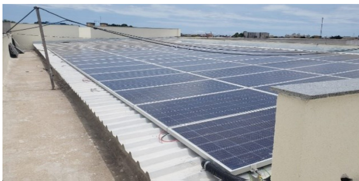
Figura 25: Instalação de módulos fotovoltaicos
