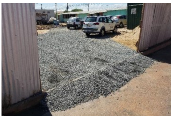
Figura 9: Acesso à obra estabilizado com brita
