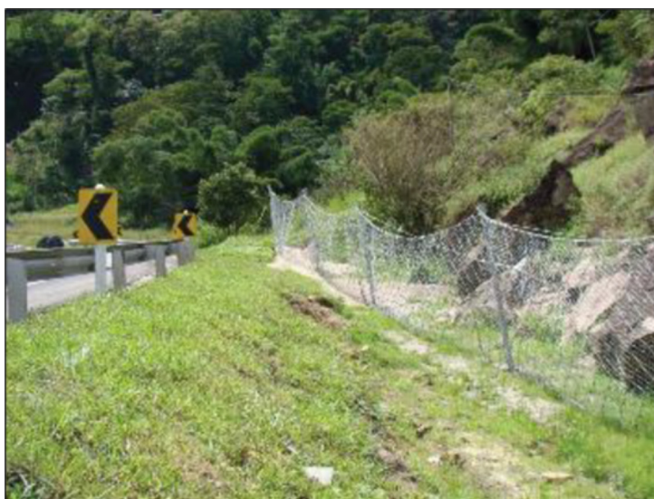
Figura 8: Barreira Dinâmica ou Flexível, Rio de Janeiro [20]
