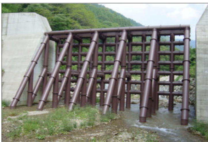
Figura 7: Barragens Sabo vazada, Nagasaki – Japão [16]
