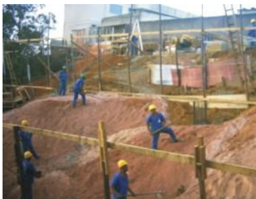
Figura 26 - Execução da Fundação da Creche Fonte: Unidade Executora do Programa HBB/BID
