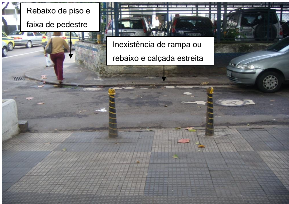
Figura 3 - Esquina da Rua Real Grandeza com Rua Hans Staden
