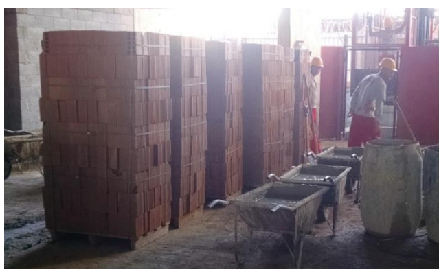
Figura 6: Pallets de blocos cerâmicos e carrinhos-de-mão contendo argamassa, enfileirados, esperando o transporte
