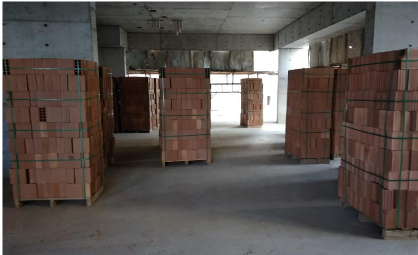
Figura 5: Pallets de blocos cerâmicos estocados aleatoriamente pelo 2º pavimento
