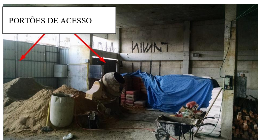
Figura 2: Central de argamassa localizada logo à frente dos portões de acesso ao canteir
