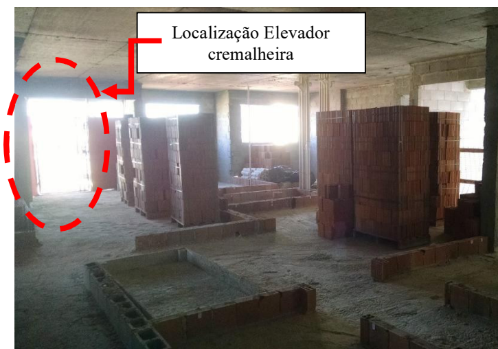
Figura 7: Pallets de blocos cerâmicos previamente estocados para as operações de elevação da alvenaria. Destaque para a elevada concentração de pallets na proximidade do elevador cremalheira
