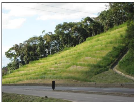
Figura 15: Recuperação de um talude com o capim vetiver [19]
