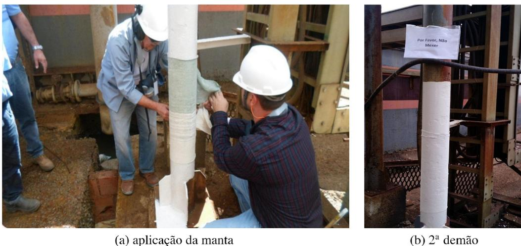
Figura 4: Pintura da superfície com tinta à base de  $Nb_2O_5$  (aplicação da manta e 2ª demão)
