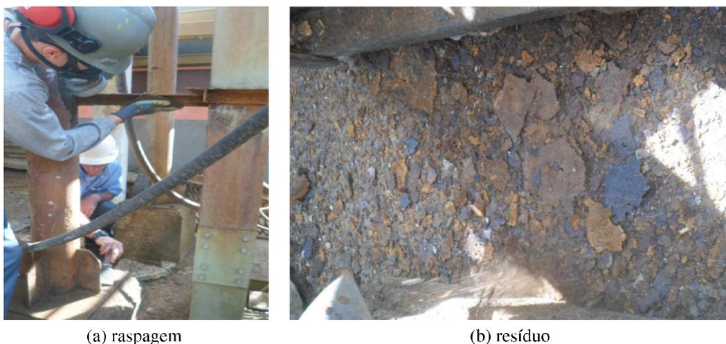
Figura 2: Processo de preparação da superfície
