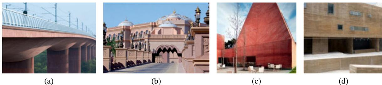
Figura 1: Exemplos de aplicações de concreto cromático: (a) estrutura em concreto armado e protendido na cor marrom avermelhada do plano de sustentação do sistema ferroviário da nova Ponte Årsta em Estocolmo-Suécia; (b) estrutura e fachada do Hotel Emirates Palace em Abu Dhabi; (c) casa das histórias Paula Rego em Cascais-Portugal e (d) Praça das Artes, em São Paulo-Brasil [22]
