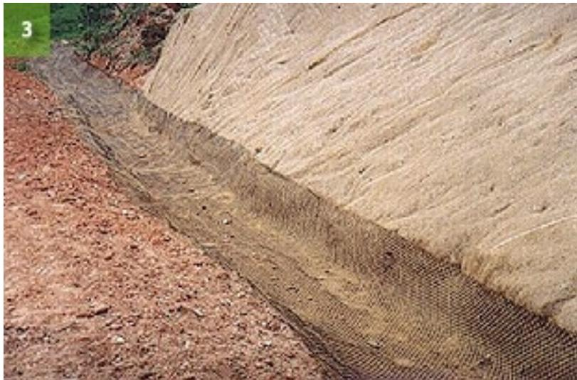
Figura 5: Canaletas revestidas com biomanta [5]
