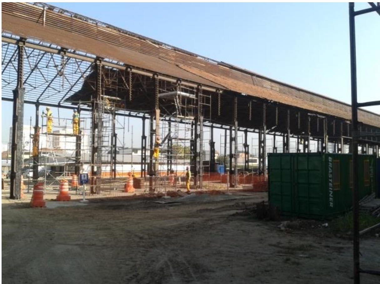
Figura 1: Estado original antes do restauro
