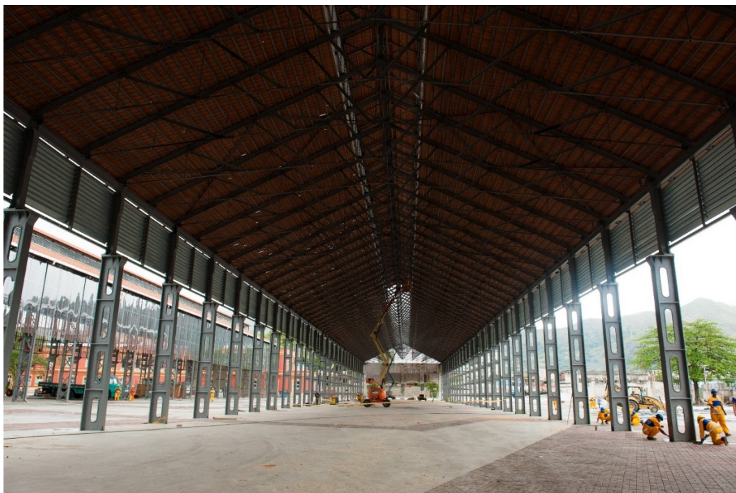
Figura 6: Vista geral após conclusão do restauro
