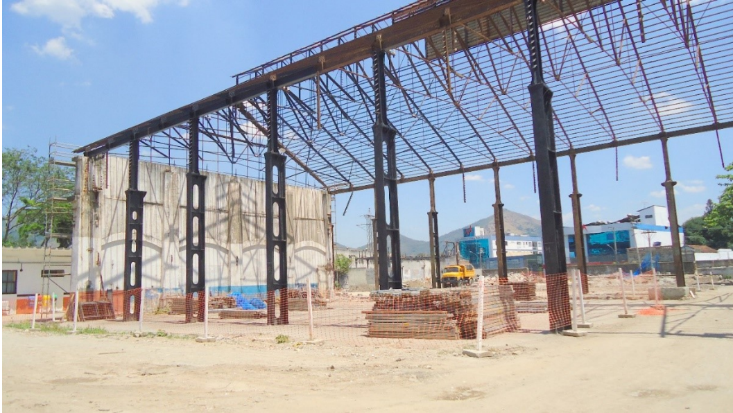
Figura 3: Vista geral de parte dos pilares pintados com primer de magnetita
