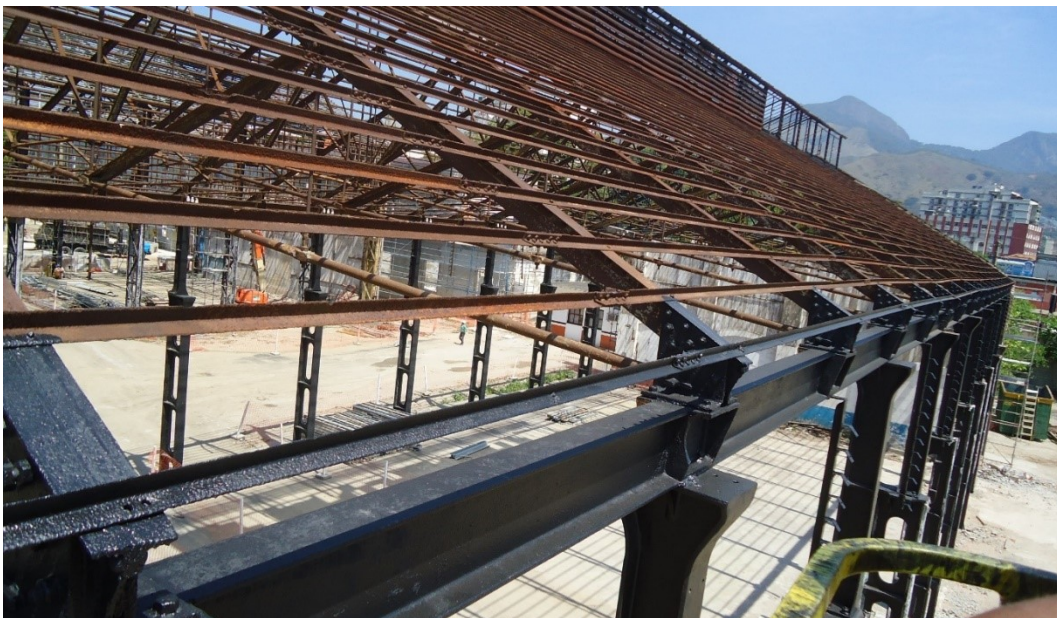
Figura 4: Vista geral das tesouras que compõem o telhado em estado inicial, as vigas transversais já pintadas com primer
