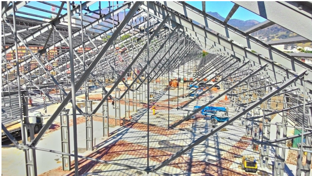
Figura 5: Vista geral das tesouras com primer e acabamento
